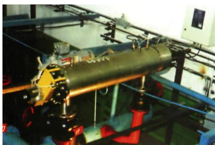
Установка УФ обеззараживания питьевой воды
