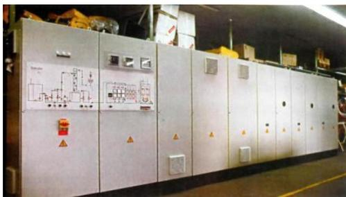
*Озонатор – аппарат (генератор) для получения озона, используемого с целью обеззараживания воды*
